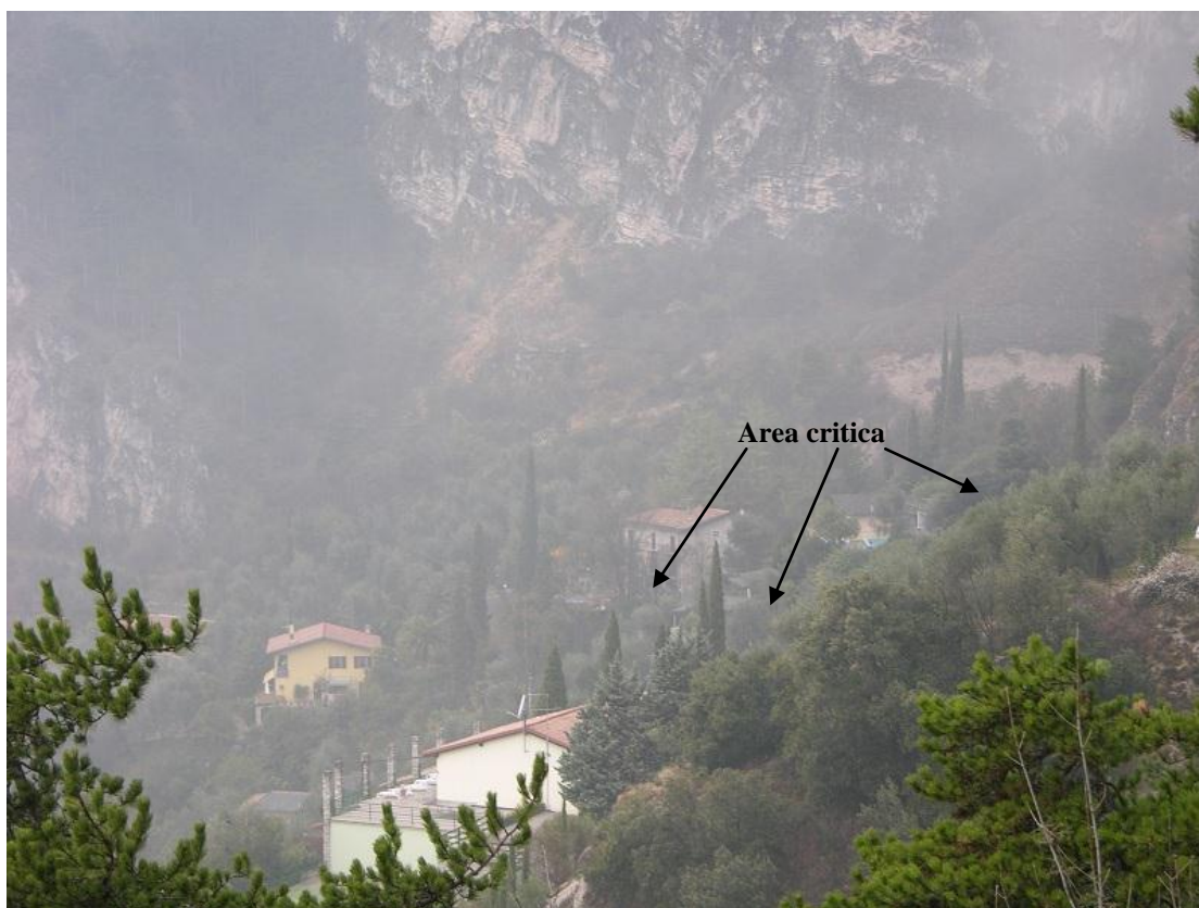
Foto 7: panoramica zona centrale critica per potenziali massi da monte
