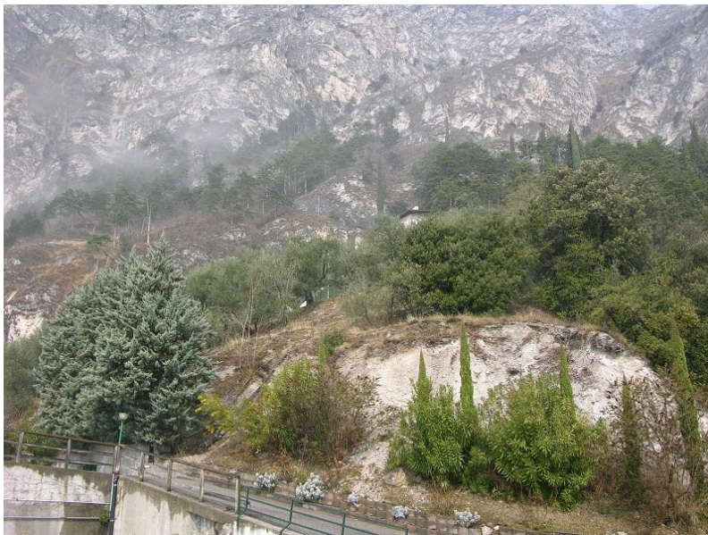
Foto 4: panoramica a monte degli edifici 4,5,6,7,8,9
