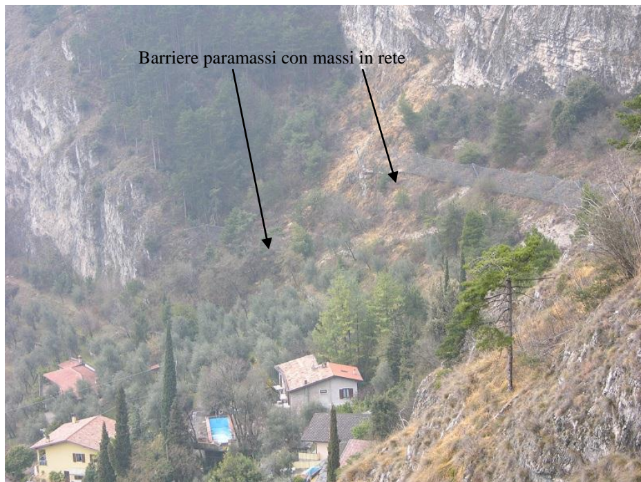
Foto 10: barriere paramassi a monte con massi in rete
