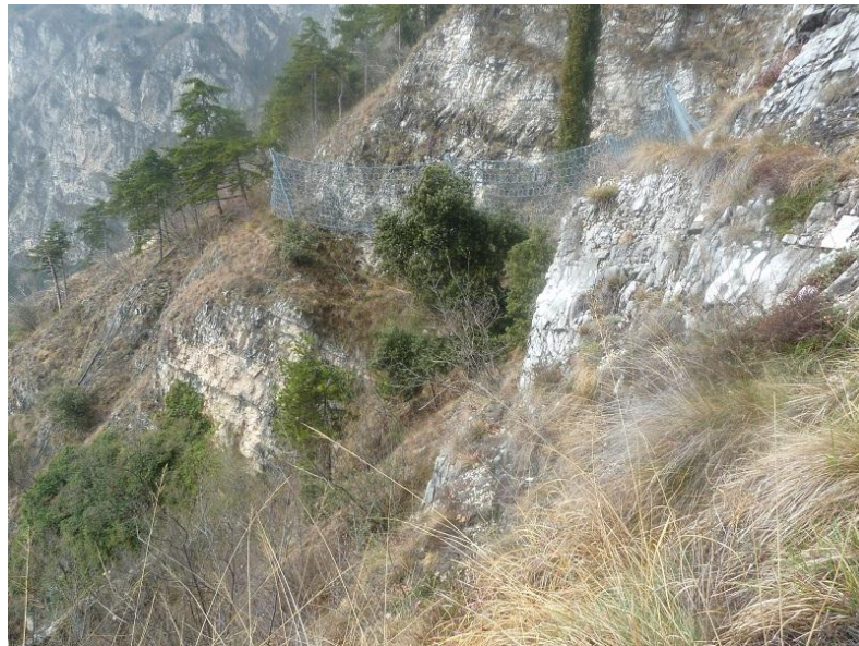
Foto 6: barriere paramassi a monte ex limonaia e lungo il versante
