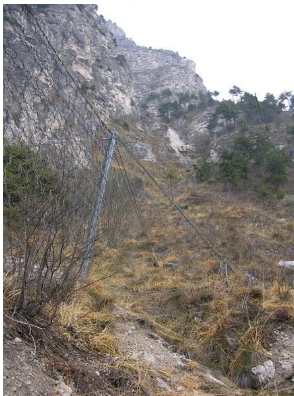
Foto 7: settore di bacino non difeso a monte della zona centrale
